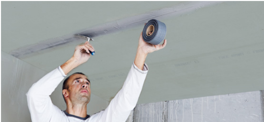
Der Glasfiter-Bewehrungsstreifen Rigips® Aquaroc FibaTape wird in die Rigips® Aquaroc ProMix Finish Spachtelmasse eingebettet. Nach ausreichender Trocknung kann mit der Nachspachtelung begonnen werden.
