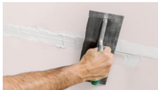
Danach erfolgt das Abziehen der vorgefüllten Fugen. Fugenfüller abbinden lassen.
