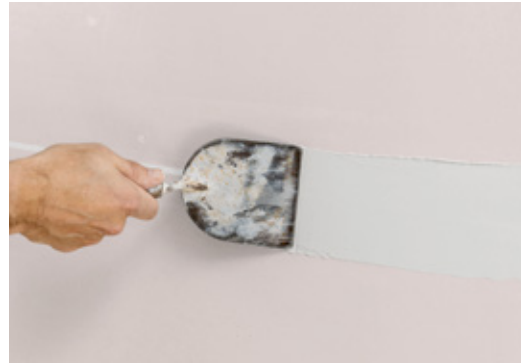
Mit dem Rigips® Vario Fugenspachtel wird ein ca. 1mm dickes Spachtelbett vorgelegt.
