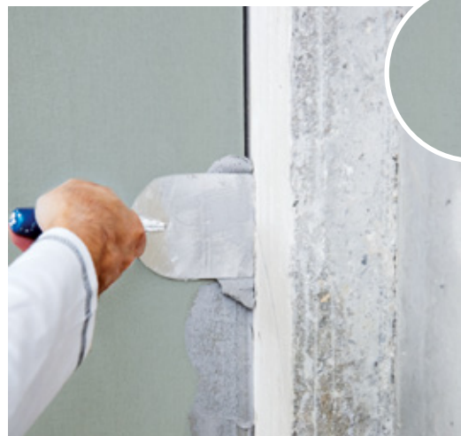
Alle Anschlüsse an angrenzende Bauteile müssen mit einem Abstand der Platten von 5mm erfolgen. Die Fugen sind mit der Systemspachtelmasse Rigips® Aquaroc ProMix Finish zu verfüllen. Nach dem Aushärten der Spachtelmasse wird der Überstand des Trennstreifens flächenbündig abgetrennt.
