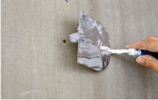
Zuerst müssen alle Schraubenköpfe geschlossen werden.
