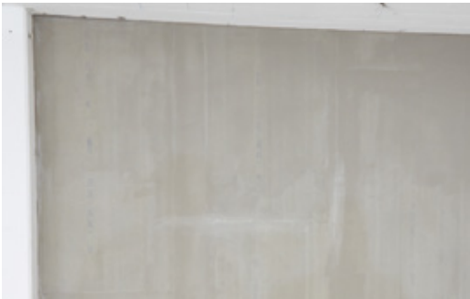
Durch das scharfe Abziehen der gesamten Oberfläche in einem nächsten Arbeitsgang wird die Qualitätsstufe 3 (Q3) erreicht.
