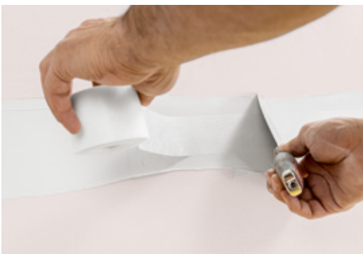
Der Rigips® Glasvlies-Bewehrungsstreifen wird auf den Fugenspachtel aufgelegt. Im Anschlussbereich der Längs- und Querfugen darf es zu keiner Überlappung der Glasvlies-Bewehrungsstreifen kommen.
