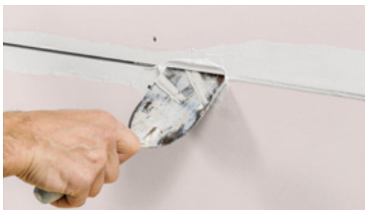
Die Fugen werden mit Rigips® Vario Fugenspachtel ausgedrückt. Dabei ist auf eine ausreichende Flankenhaftung an den Plattenkanten zu achten.
