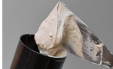
2. Die angerührte Rigips® Vario Fugenspachtelmasse wird zügig in die leicht schräg gestellte Kartusche eingefüllt.
