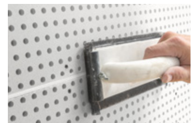
Nach ca. 3 Stunden die Fugenbereiche und überspachtelten Schraubenköpfe abschliessend schleifen und für die weitere Oberflächenbehandlung vorbereiten.
