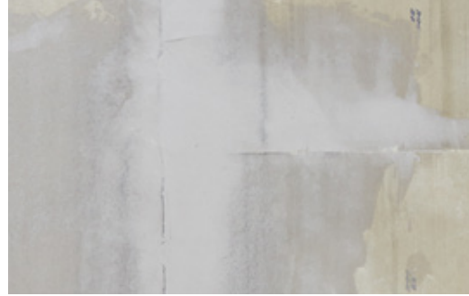
Danach folgt die Verspachtelung der Fugenbereiche sowie das scharfe Abziehen der Oberfläche (Q2).
