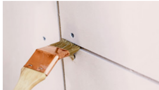
Die Plattenkanten müssen entstaubt und vorgehässt respektive mit Rigips® Rikombi Sperre neutral grundiert werden.
