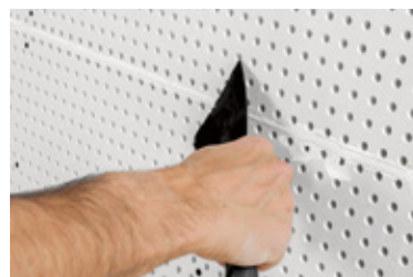
Die Fugen anschliessend in entgegengesetzter Richtung glattstreichen.
