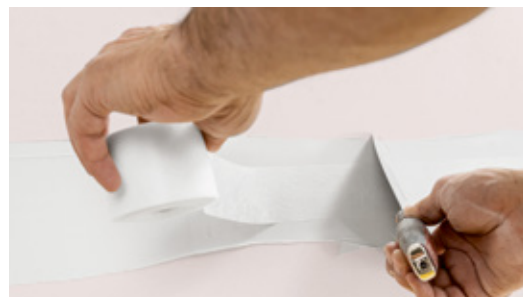
Der Rigips® Glasvlies-Bewehrungsstreifen wird auf den Fugenspachtel aufgelegt. Im Anschlussbereich der Längs- und Querfugen darf es zu keiner Überlappung der Glasvlies-Bewehrungsstreifen kommen.
