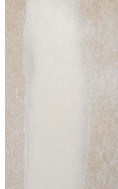
Fugenbild mit Rigidur® SK-Kanten in Klebefugentechnik, SK-Kanten auf Stoss stumpf verlegt und mit Rigidur® Fugenkleber verklebt. Überspachtelung der Fuge und Befestigungsmittel mit Rigips® Vario Fugenspachtel.
