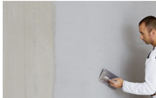
Ein glatter Untergrund entsteht.
