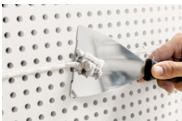
Nach ca. 30 Minuten den leicht angezogenen Fugenspachtel vorsichtig mit dem Rigips® Stielspachtel abstossen.
