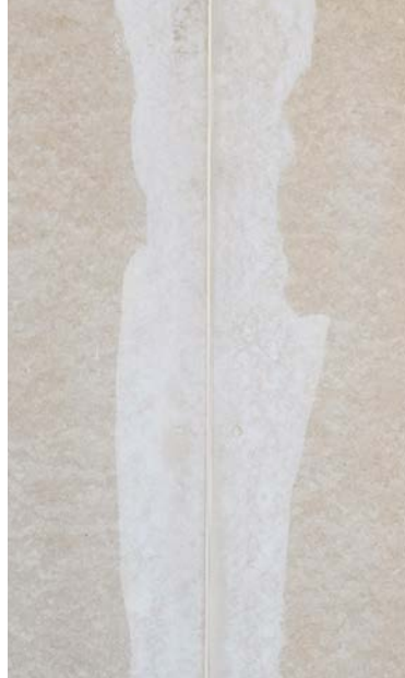
Fugenbild mit Rigidur® SK-Kanten in Spachtelfugentechnik mit 5 mm Fugenspalt und Verarbeitung mit Rigips® Vario Fugenspachtel.
