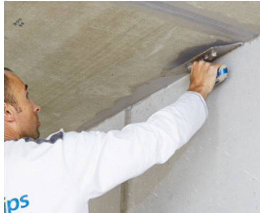
Die Fugen werden mit Rigips® Aquaroc ProMix Spachtelmasse ausgedrückt.
