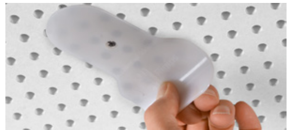
Die Schraubenköpfe mithilfe einer Rigips® Schraubenkopfschablone überspachteln.
