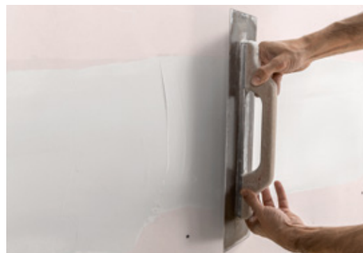
Nach dem Abbinden des Fugenspachtels kann die Nachspachtelung erfolgen.
