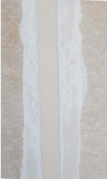
Fugenbild mit Rigidur® AK-Fuge, Rigips® Bewehrungsstreifen und Rigips® Vario Fugenspachtel.
