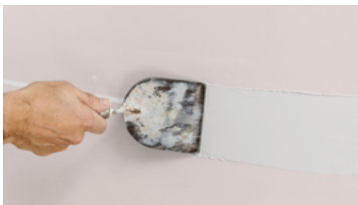
Mit dem Rigips® Vario Fugenspachtel wird ein ca. 1 mm dickes Spachtelbett vorgelegt.
