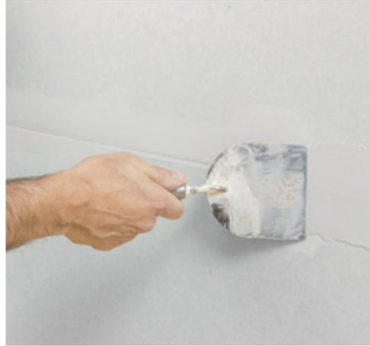
*Ca. 1mm dicke Spachtelschicht auftragen*
