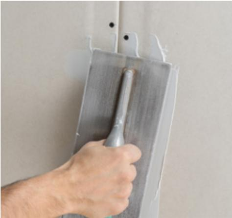
Die Längsfugen werden quer zur Plattenkante mit dem Rigips® Promix Systemspachtel ausgedrückt.
