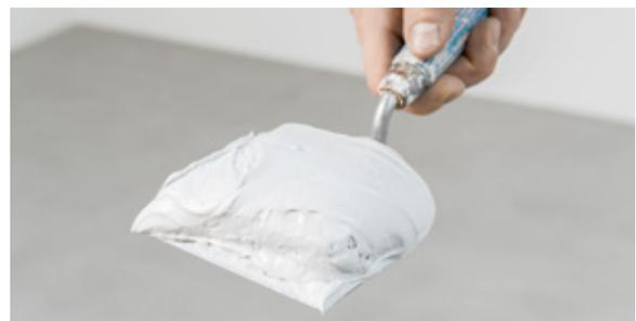
*Die gebrauchsfertige Spachtelmasse wird direkt dem Eimer entnommen und verarbeitet.*
