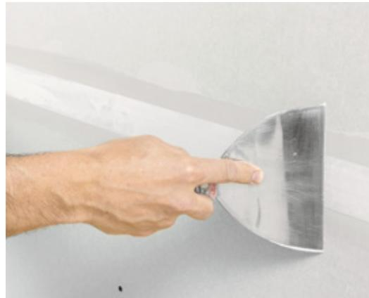
*Die Einbettung des Rigips® Papier-Bewehrungsstreifens erfolgt mit zusätzlichem Materialauftrag.*
