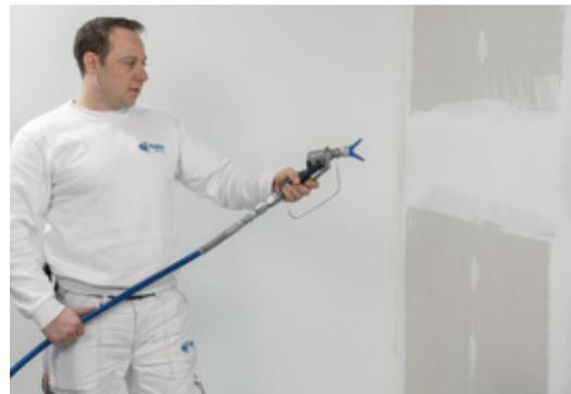
Die Fertigspachtelmasse wird in gleichmässigen Bewegungen vollflächig auf die Wandoberfläche aufgebracht. Für die Qualitätsstufe 4 (Q4) ist ein zweimaliger Auftrag erforderlich.
