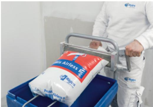
Der Foliensack mit der Fertigspachtelmasse wird auf die Sackmangel aufgelegt und geöffnet. Die Spachtelmasse muss komplett in den Grossmengenbehälter des Gerätes entleert werden.
