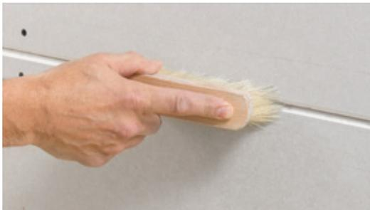
*Die Entfernung des Gipsstaubes sorgt für eine gute Haftung.*
