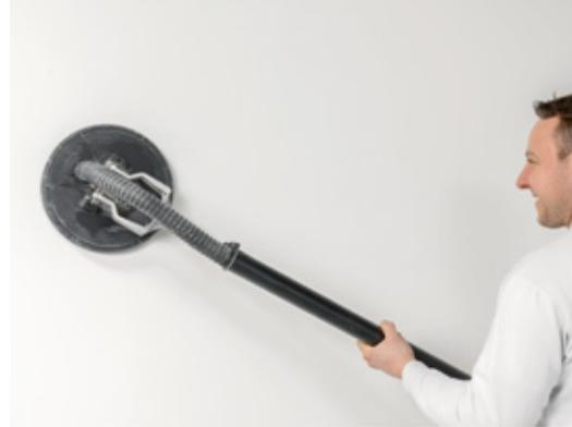
*Ob ein Nachschleifen (manuell oder maschinell) der durchgetrockneten Spachtelmasse erforderlich ist, hängt von der vereinbarten Oberflächenqualität bzw. vorgegebenen Oberflächengüte ab.*
