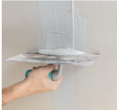
Danach erfolgt das Abziehen der vorgefüllten Fugen. Fugenfüller trocknen lassen.
