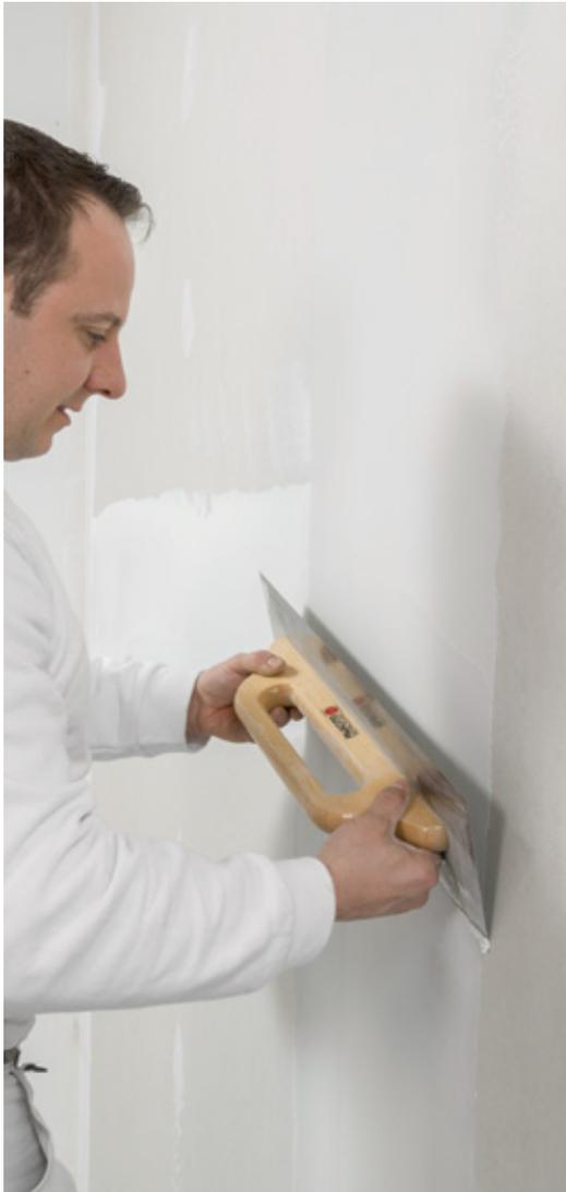
*Der Finish wird mithilfe eines Glättspachtels auf den Untergrund aufgetragen.*
