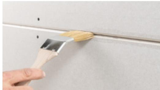
*Die Querkanten müssen vorgelässt oder mit Rigips® Rikombi Sperre neutral grundiert werden, damit dem Rigips® Systemfugenfüller das Wasser nicht zu schnell entzogen wird und nicht zu schnell austrocknet.*
