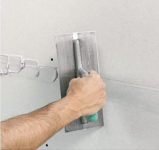
*Querfugen werden ausgedrückt. Anschliessend trocknen lassen.*
