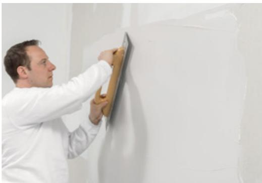
Die frisch aufgetragene Spachtelmasse wird mit einem Flächenspachtel glatt abgezogen und muss vollständig getrocknet werden lassen.
