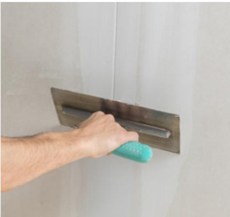
Nach vollständiger Trocknung, wird eine ca. 1 mm dicke Spachtelschicht aufgetragen.
