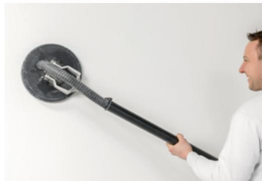
Falls erforderlich, kann die Oberfläche maschinell mit einem 120er- oder manuell mit einem 220er-Schleifpapier abgeschliffen werden.
