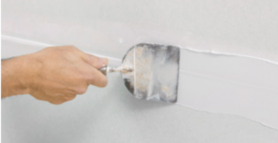
Ca. 1mm dicke Spachtelschicht auftragen.
