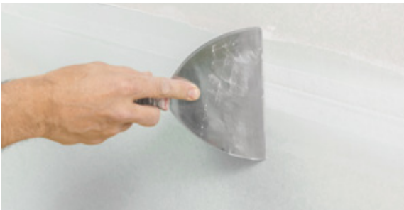
Der Rigips® Glasvlies-Bewehrungsstreifen wird ohne zusätzlichen Materialauftrag abgezogen.
