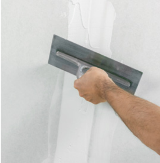
Die Längsfugen werden quer zur abgeflachten Kante mit dem Rigips® Systemfugenfüller ausgedrückt und scharf abgezogen.
