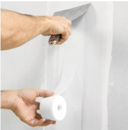
Gleich danach erfolgt das Einlegen des Rigips® Glasvlies-Bewehrungsstreifens.
