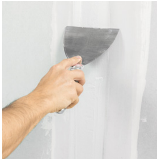
Der Rigips® Glasvlies-Bewehrungsstreifen wird ohne zusätzlichen Materialauftrag abgezogen.
