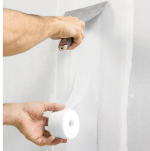
Den Rigips® Glasvlies-Bewehrungsstreifen von oben einlegen ...
