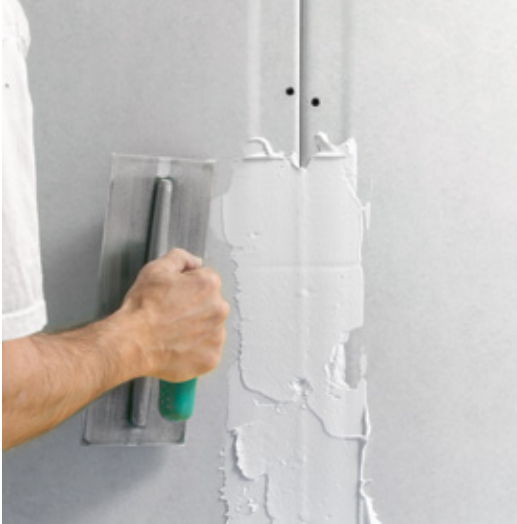
Die Längsfugen werden quer zur Vario Kante mit Rigips® Vario Fugenspachtel ausgedrückt.
