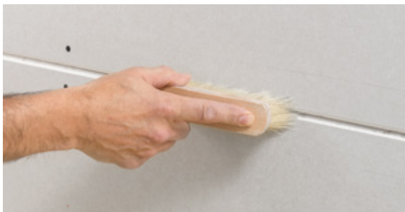
Die Entfernung des Gipsstaubes sorgt für eine gute Haftung!
