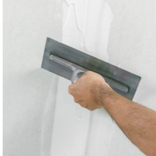
Danach erfolgt das Abziehen der vorgefüllten Fugen.
