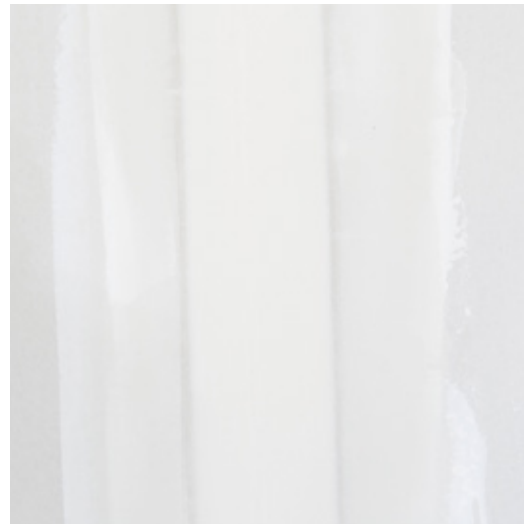
Die fertige Längsfuge nach dem Abziehen.
