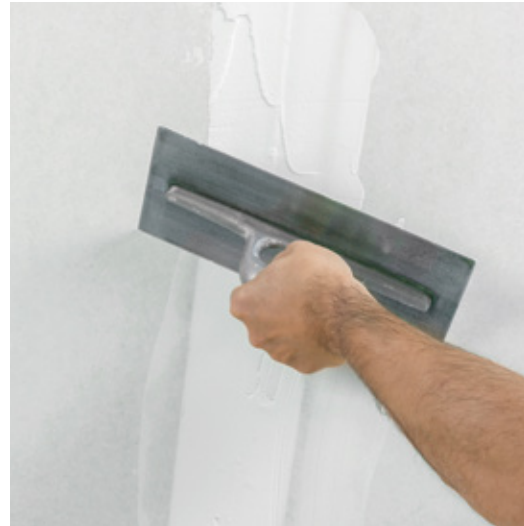
Danach erfolgt das Abziehen der vorgefüllten Fugen.
