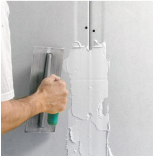
Die Längsfugen werden quer zur Vario Kante mit Rigips® Vario Fugenspachtel ausgedrückt.
