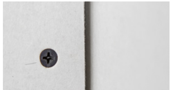
Gefaste Kante (linke Platte) an Vario-Kante (rechte Platte).
