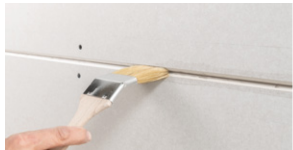
Die Querkanten müssen vorgemischt oder mit Rigips® Rikombi Sperre neutral grundiert werden, damit dem Rigips® Systemfugenfüller das Wasser nicht zu schnell entzogen wird und nicht zu schnell austrocknet.
