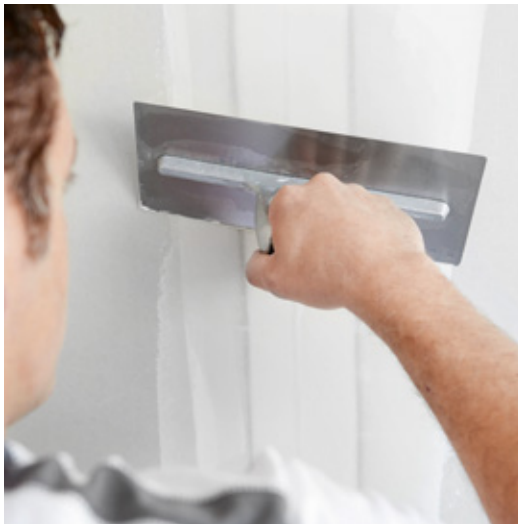
Es ist auf ein blasenfreies Verfüllen der Fugen zu achten.
