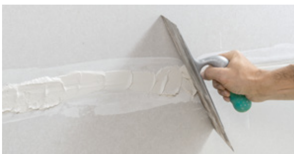
Die Quertugen werden mit dem Rigips® Fugenfüller ausgedrückt.
